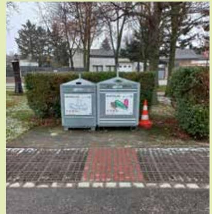
Die Altglascontainer-Insel in der Pointengasse wurde mit neuen Rasengittersteinen, die teilweise mit Pflastersteinen bestückt wurden, befestigt und somit sauber befahr- und begehbar gemacht.
